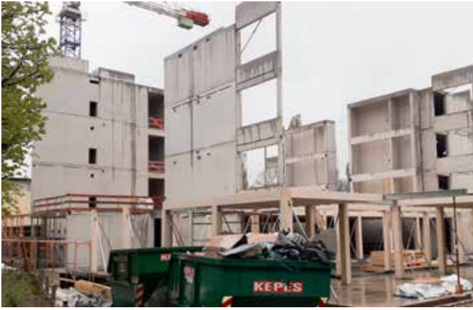
Beginn der Holzbauarbeiten zum Monatsbeginn April.
