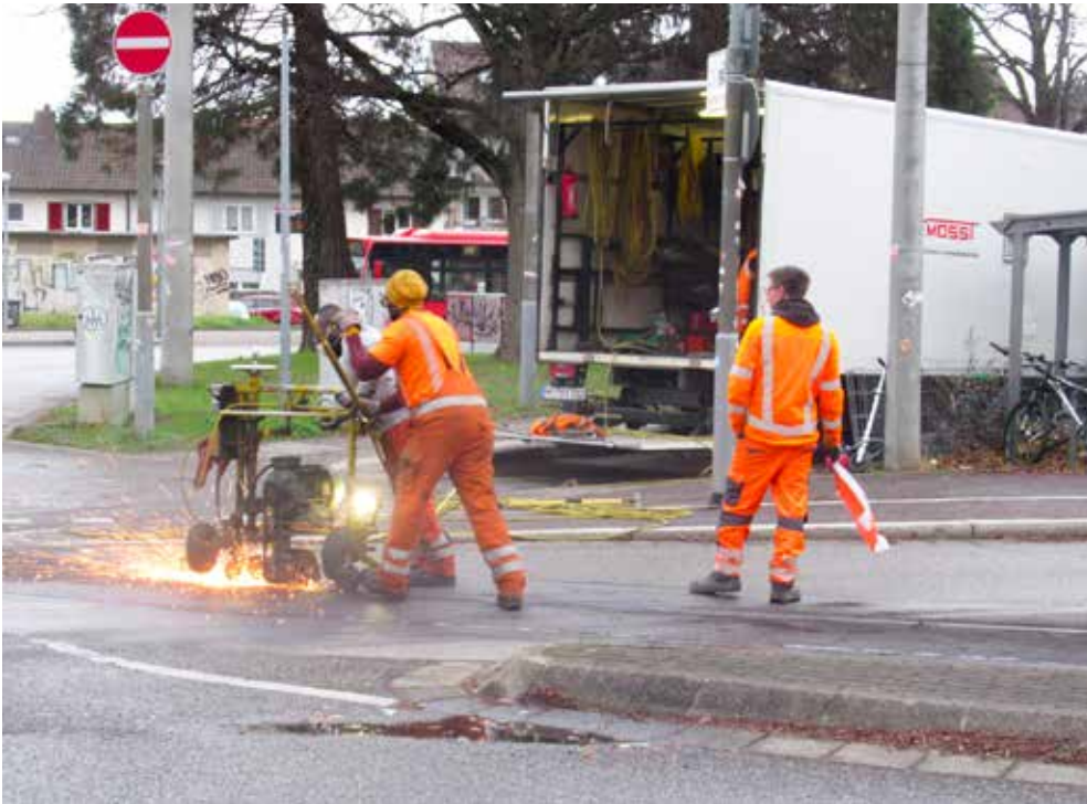
An zwei Tagen wurden die Schienen in der Laßbergschleife von einer Firma aus Nordrhein-Westfalen abgeschliffen.
