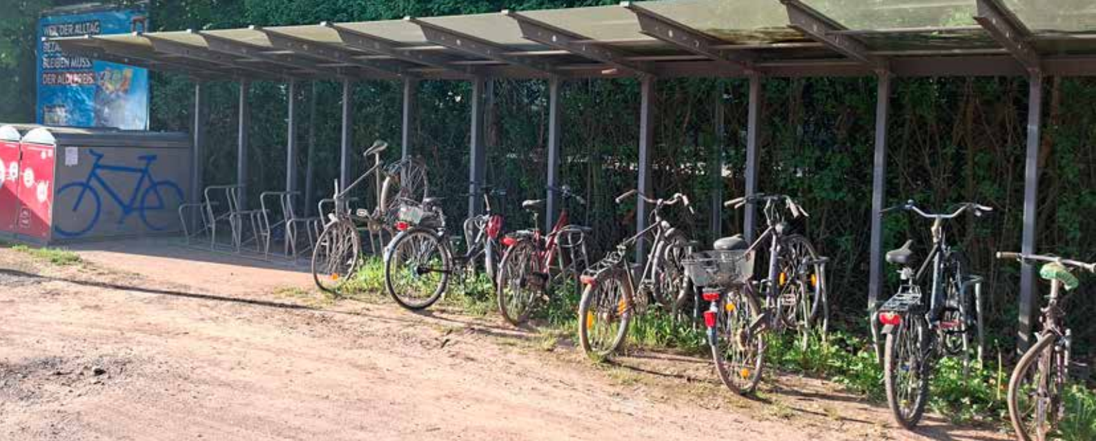
Radunterstellplatz auf dem mit Schlaglöchern übersäten und staubigen Gelände.
