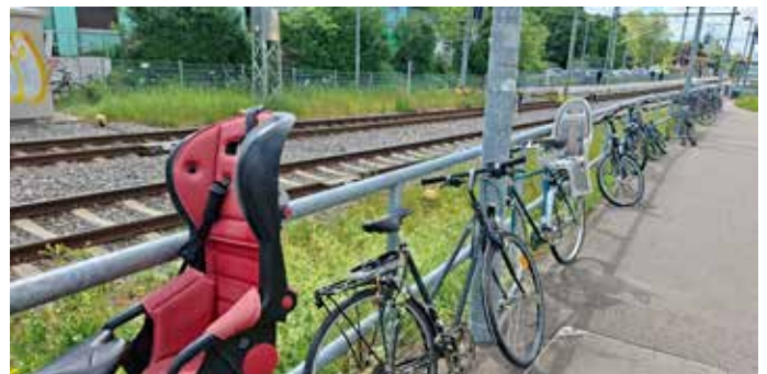
Stellplätze für Räder sind nicht ausreichend: Auf beiden Seiten muss am Zaun entlang geparkt werden.
