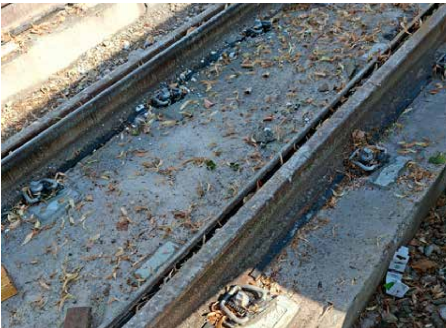
Bild 1: Die Schiene liegt in der Länge auf dem synthetischen Ethylen-Propylen-Dien-Monomer-Kautschuk
